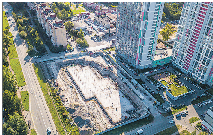
Строительство взрослой поликлиники
