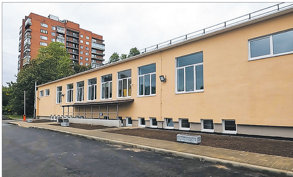
Новая станция скорой помощи на Учительской улице
