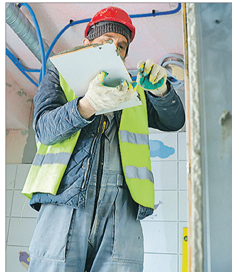
Ход капитального ремонта поликлиники № 118
